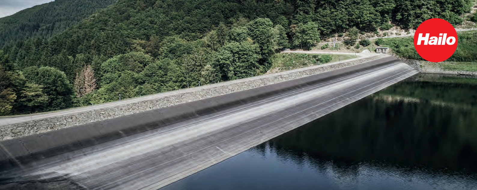
Talsperre (Trier), GLOBALift im Schieberschacht, 50 m tief
